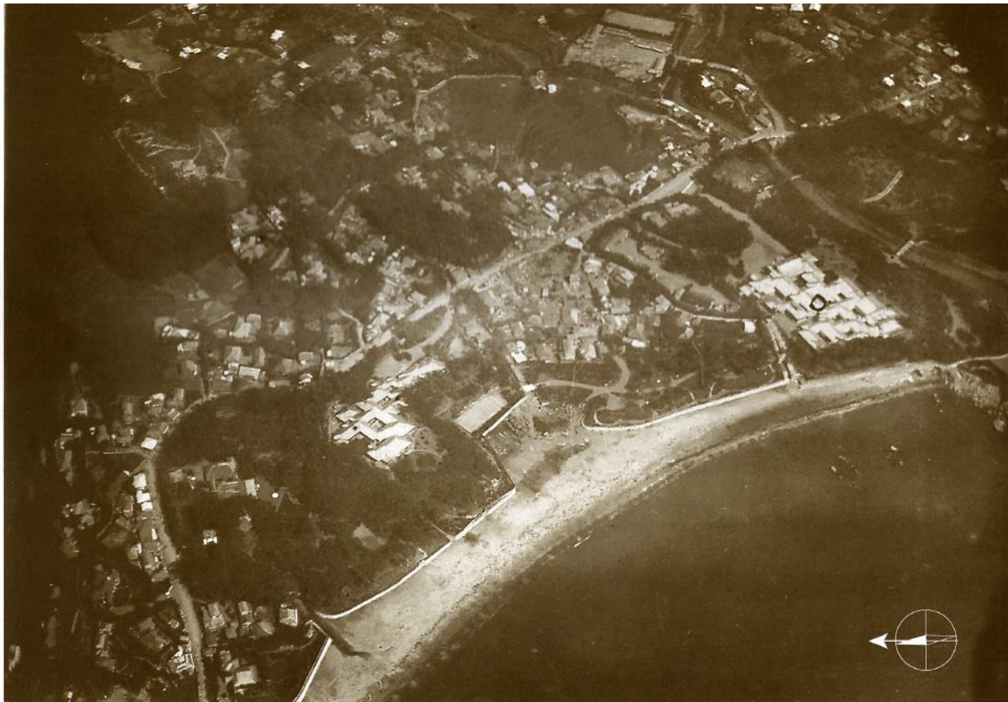
葉山町一色（三浦郡葉山村） 葉山御用邸（○）は強震で倒壊した。画面中央下の付属邸は古砂丘上にあったので無事であった 9月9日 撮影横 横須賀海軍航空隊 撮影F-5式7号飛行艇。（防衛研究所 戦史研究センター） The Hayama Imperial villa collapsed by severe earthquake.
